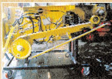
Dank des Montagegestells werden pro Reparatur fünf Mann-Stunden gespart.
